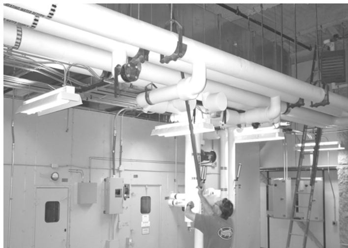
ภาพที่ 8 ภาพแสดงการใช้งานอุปกรณ์ช่วยทดสอบ หรือถอด ประกอบอุปกรณ์ตรวจจับในที่สูงโดยไม่ต้องใช้บันได
